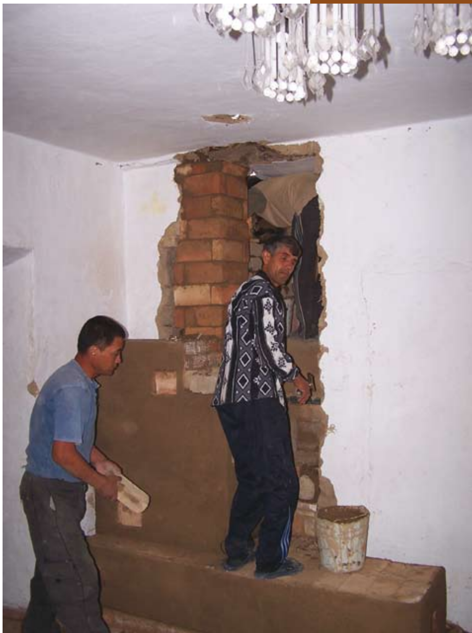
Сохранение тепла в доме и улучшение здоровья семьи за счет более эффективной печи в сельском доме
